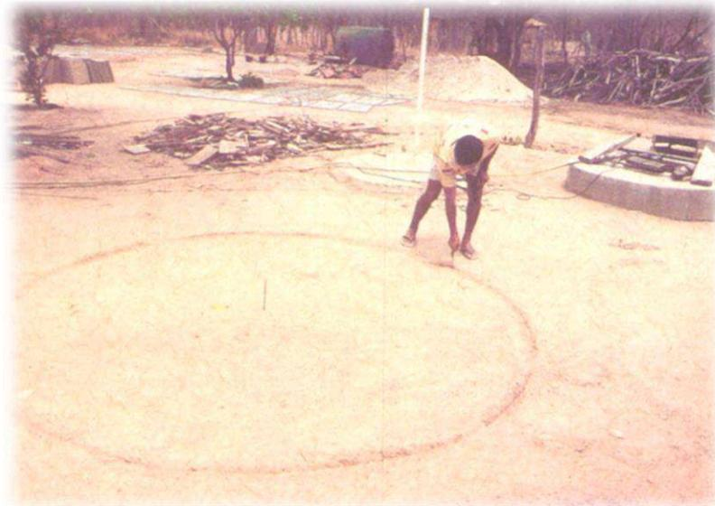
Para a construção da cisterna, deverá ser feita uma escavação cilíndrica com 8,00 m de diâmetro e 1,80 m de profundidade.
