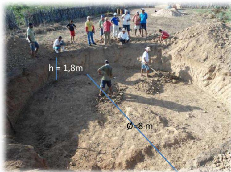
A terra retirada deve ser depositada observando uma distância suficiente para que não desmorone para dentro do buraco, deixando um espaço de pelo 0,5 m em torno da borda da cavidade, tendo o cuidado de amontoar a terra em dois semicírculos, dispostos
