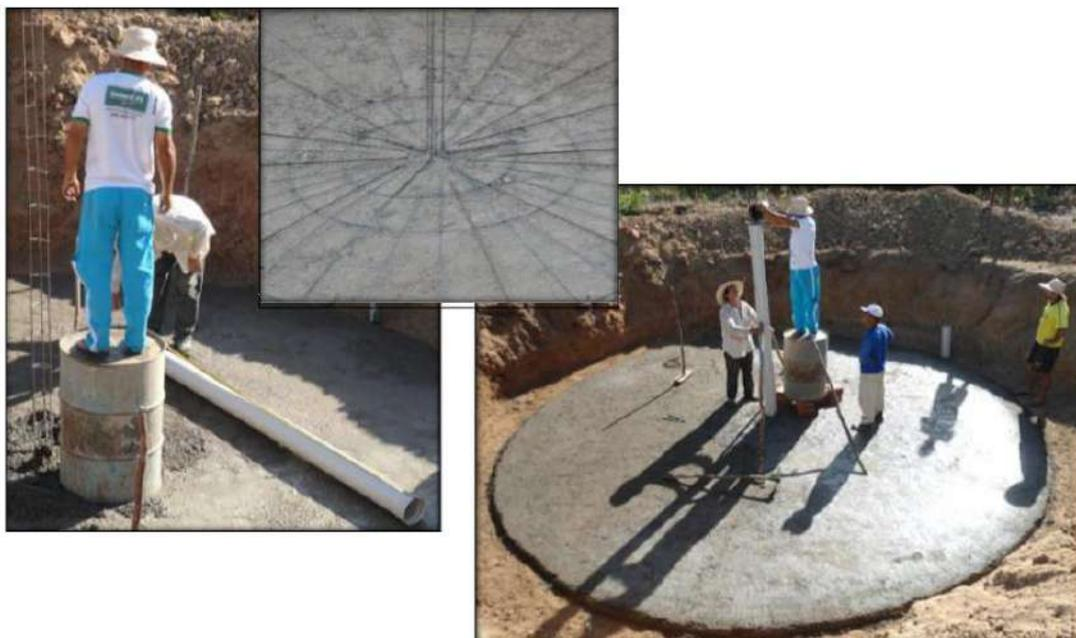
Dentro do cano deve ser colocada 1 barra de ferro CA - 50 de 10 mm com 2,90 m de comprimento, de modo a conferir resistência à coluna. A ferragem vai extrapassar em 20 cm as duas extremidades do cano de PVC, para fixação no piso na extremidade inferior e da bandeja na extremidade superior.
